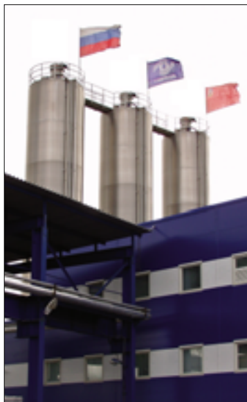
Хранилища сырья силосного типа на заводе «Терна Полимер».
