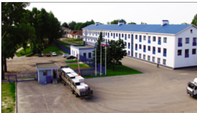
Здание заводоуправления Петушинского металлического завода
