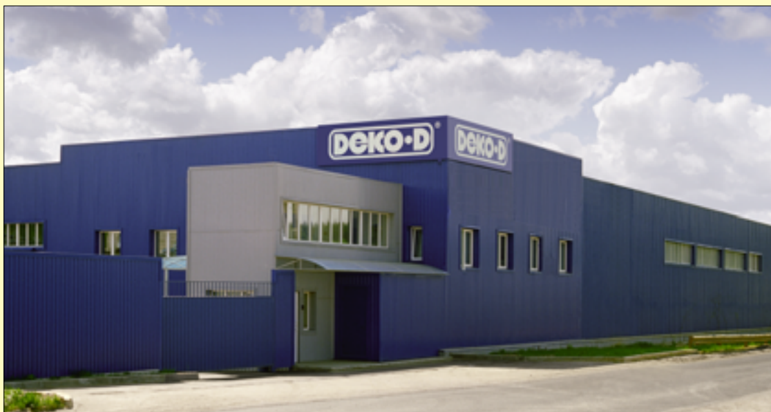
Производственно-складская база компании «Деко-Д» на Ленинградском шоссе
